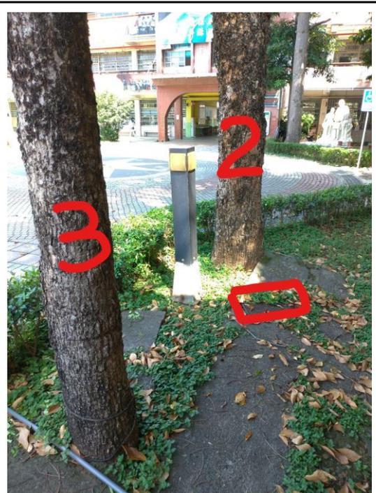
圖6：2、3號木棉樹根部與自來水水表箱管線重疊
